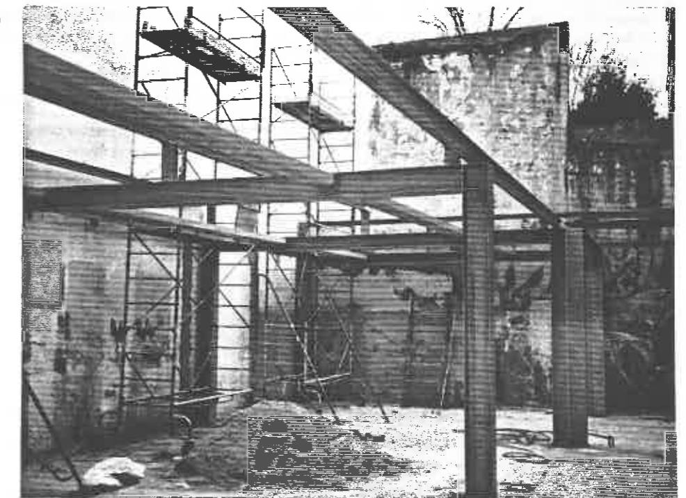
Saint-Charles en chantier...
