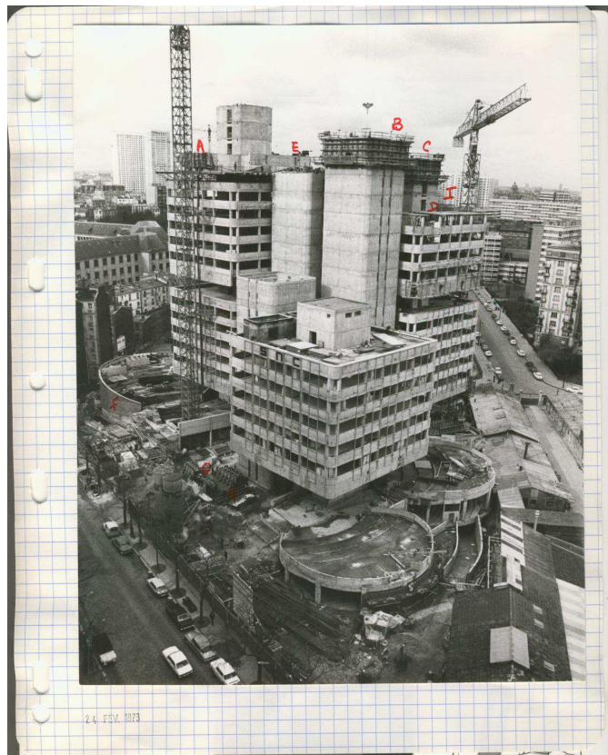
Construction du Centre de Tolbiac, photographie de chantier du SCARIF 1190W 3
